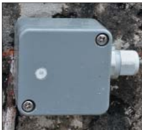
Рис. 3. Комбинированный датчик температуры и относительной влажности
