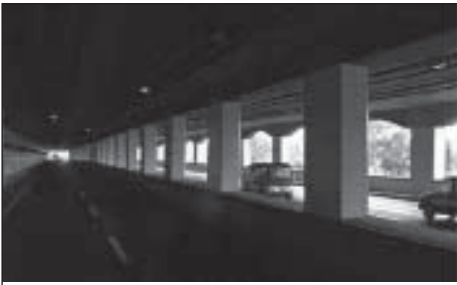
Рис. 5. Автомобильный тоннель, о. Тайвань
