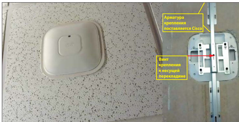
Рис. 7. Крепление на потолке
