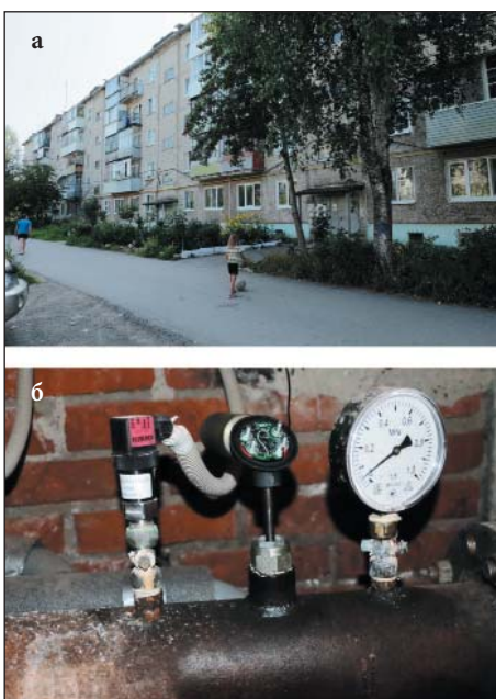
Рис. 12. Объект 1: а) общий вид; б) место установки датчика (подвал дома)
