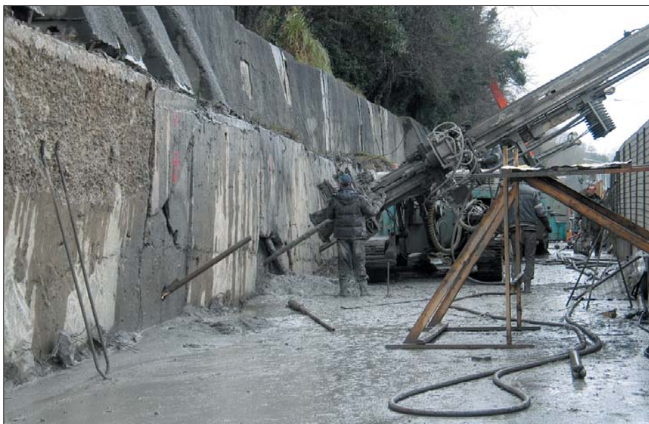
Рис. 3. Монтаж противооползневой стенки
