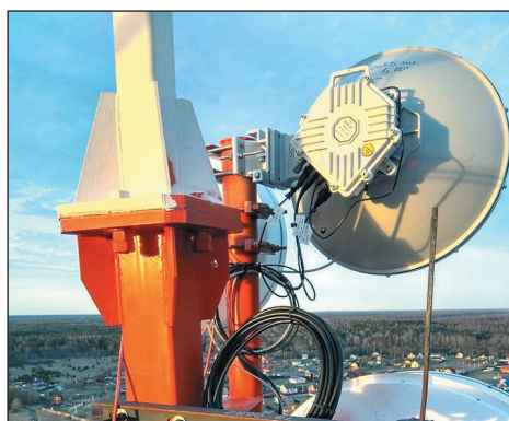
Рис. 1. Радиомост ДОК РРС-10G-E на телекоммуникационной вышке МТС
