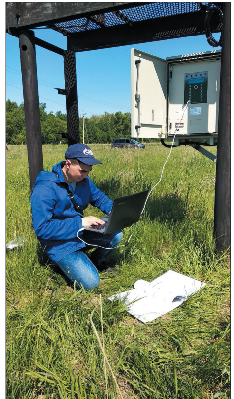
Рис. 9. Настройка блока управления и радиоканала реклоузера
